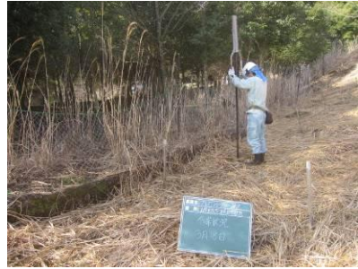
2013年3月 獣害対策用ネット補修工事
